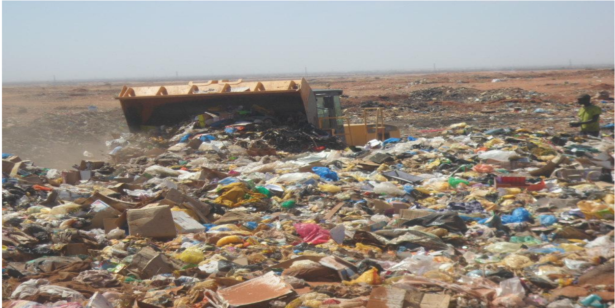
صوره رقم ( 14 ) طريقة دفن النفايات بالمكب النهائي بمنطقة الدراسة
